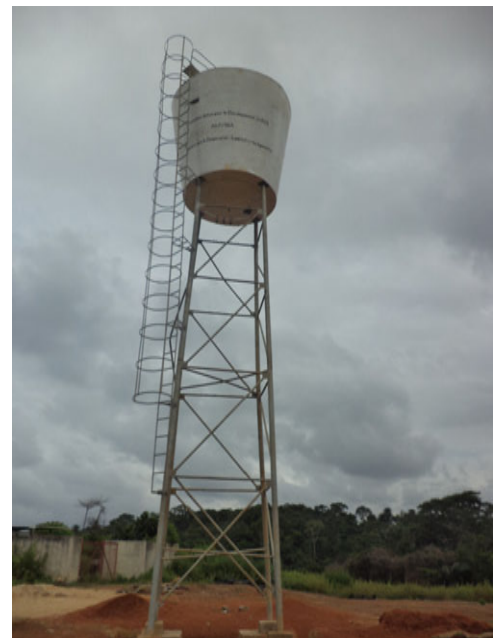
Figure 6. Château d'eau à Mani.
